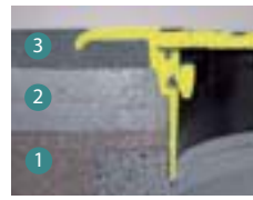
1 - stabilizační vrstva (nosná) 2 - spodní živичná vrstva (binder) 3 - vrchní živичná vrstva (obrus)
