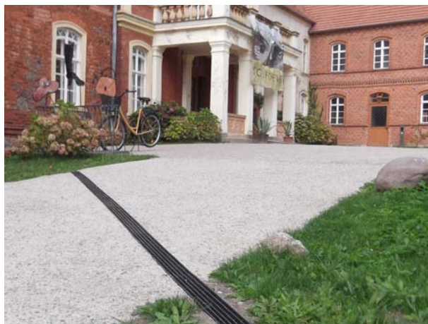
HYDROline, Objekt: Přístup k zámku Meyenburg
