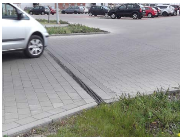
HYDROline, Objekt: Vjezd na parkoviště, Neuruppin
