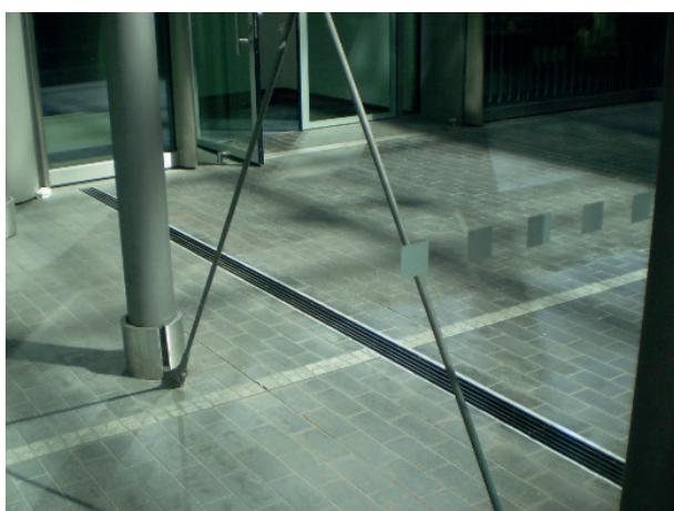
HYDROline, Objekt: Pasáž Axel Springer, Berlín
