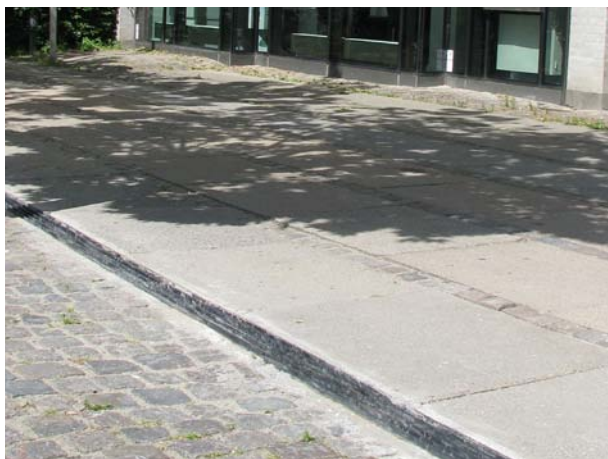
HYDROline, Objekt: Lynqby, Dánsko
